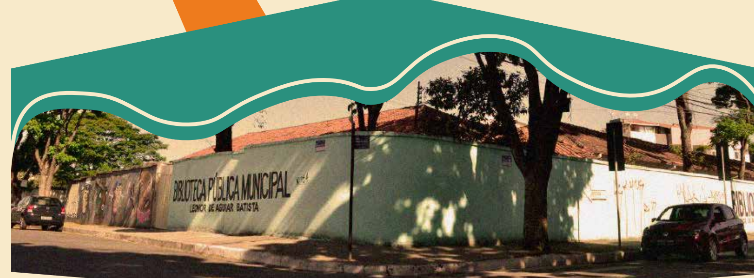
Muro externo. Fonte: acervo próprio, 2020.
